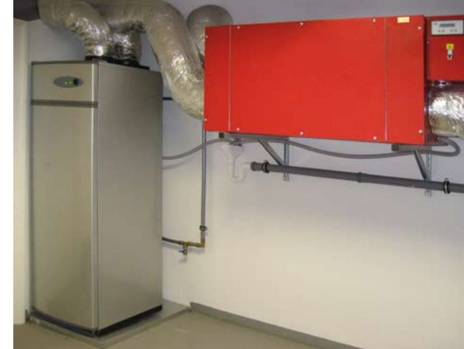
Die Zentralgeräte der PROXON®-Lüftungsheizung sind das Herzstück der Anlage. Hier wird die verbrauchte Luft im Haus permanent gegen gereinigte und angewärmte Frischluft ausgetauscht und in das Rohrsystem geleitet. Aus der Abwärme wird Warmwasser produziert.
